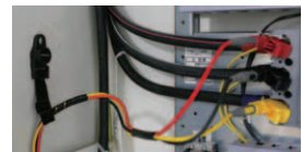
クリップが電圧コードの自重で金属端子から外れやすい場合、Z5004で電圧コードを補助して設置できます。
